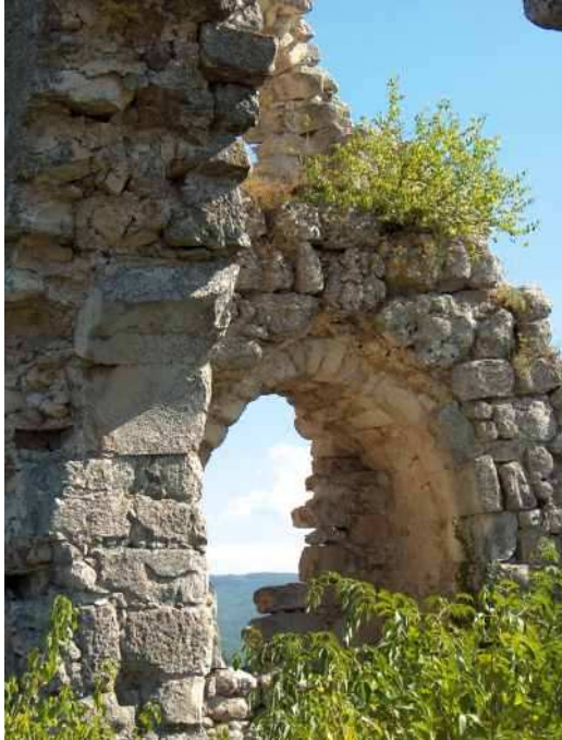
Fig. 30. Turnul citadelei. Vedere parțială spre sud-est
