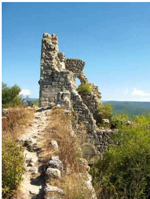
Fig. 29. Turnul citadelei. Vedere spre sud-est
