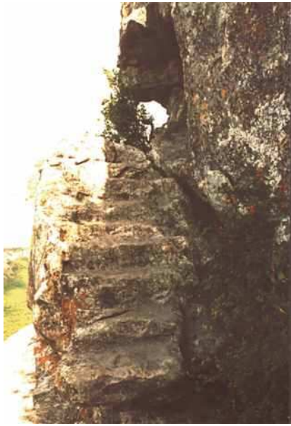
Fig. 232. Mangop. Scara de acces între cele două niveluri ale complexului nr. 1
