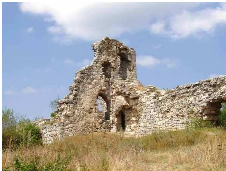
Fig. 26. Zidurile și turnul citadelei. Vedere dinspre platou
