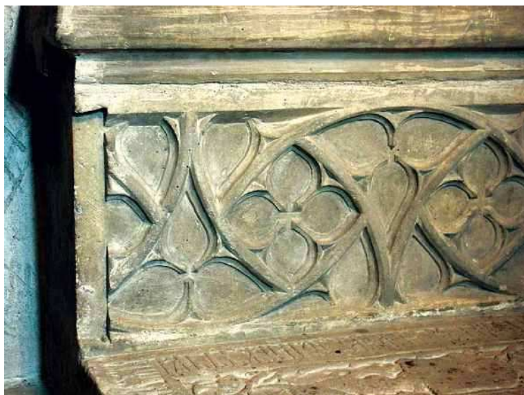
Fig. 173. Soclul mormântului doamnei Maria, cu locul de îmbinare în „coadă de rândunică” (Biserica Mănăstirii Putna)
