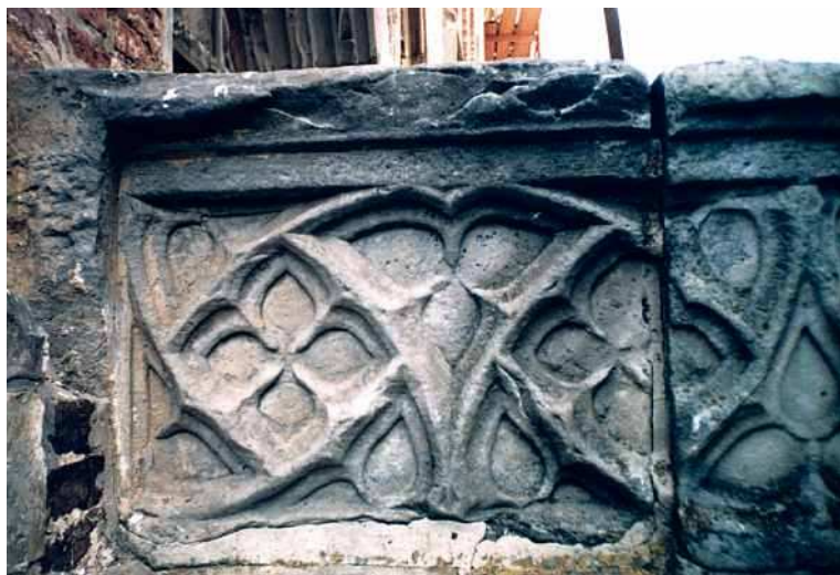
Fig. 172. Fragment din balustrada de la Bălinești
