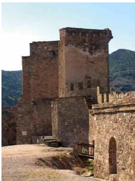
Fig. 49. Soldaia. Vedere din interior a porții de acces în cetate
