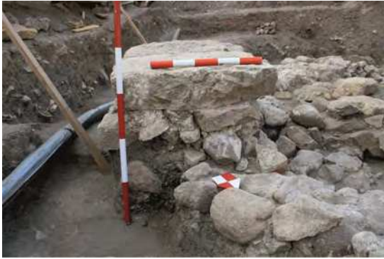
Fig. 12. - Detaliu din zidăria absidei, cu fragmentul de soclu scos in afara fundației
