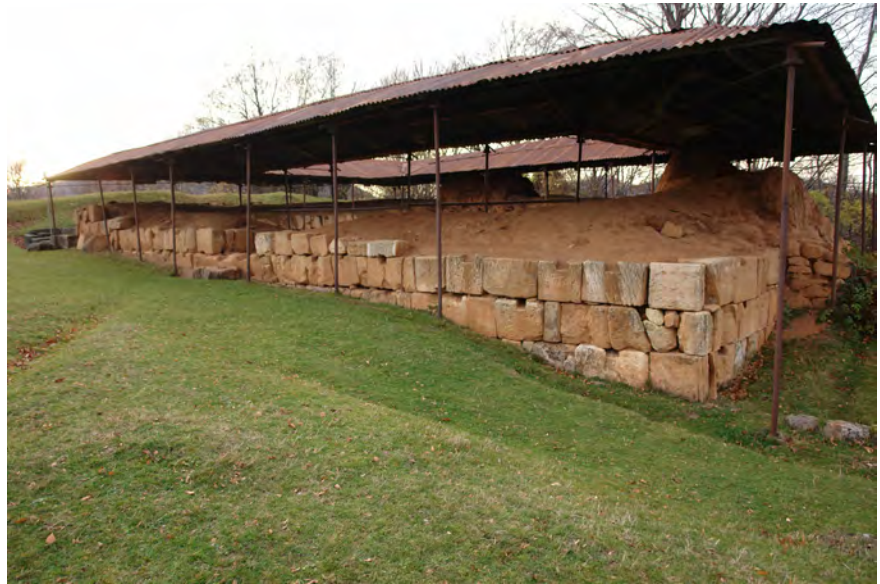
Fig. 11 Costești – Cetățuie, turnul – locuință nr. 1 Costești – Cetățuie, dwelling – tower nr. 1
