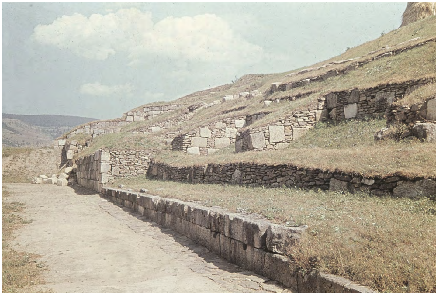
Fig. 21 Blidaru – zidul din blocuri de calcar și bucăți de micașist Blidaru – wall of limestone blocks combined with local stones (mica schist)
