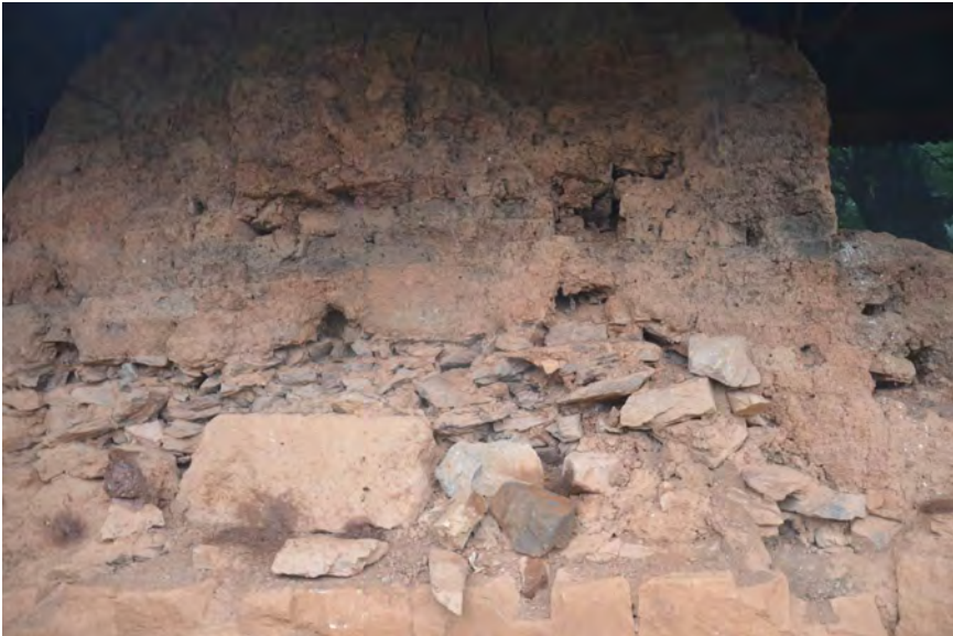
Fig. 12 Costești – Cetățuie, turnul – locuință nr. 1, segment din elevația de cărămizi Costești – Cetățuie, dwelling – tower no. 1, detail of the mudbrick wall
